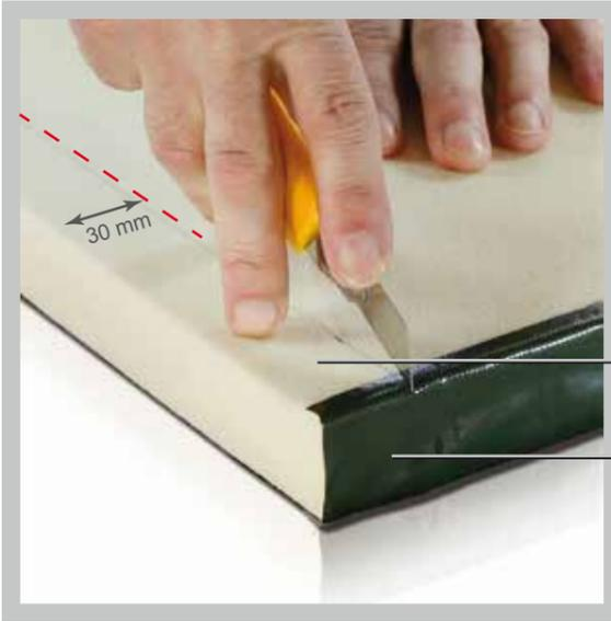
Die mit der Linie markierten Seiten, ohne Klebeband, können bis zu 30 mm beschnitten werden
