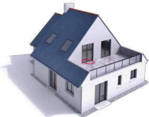
Mit UltraVIP-Terrassendämmung sind annähernd gleiche Aufbauhöhen der Fußböden zwischen Innenraum und Terrasse möglich, störende Stufen entfallen.
